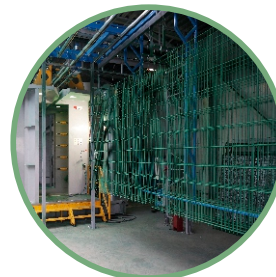
Покрытие полимерным составом
